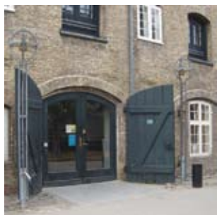
De gamle porte er bevaret som et af bygningens vigtige udtryk mens nye døre gør bygningen åben og tilgængelig
