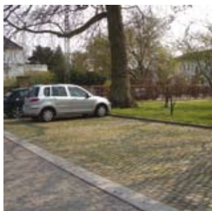
Belægningsskift markerer p-zone i forhold til gade og plæne
