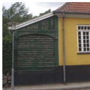
Eksempel på oprindelig udbygning med ensidet taghældning, grønt tagværk og hvid gesims
