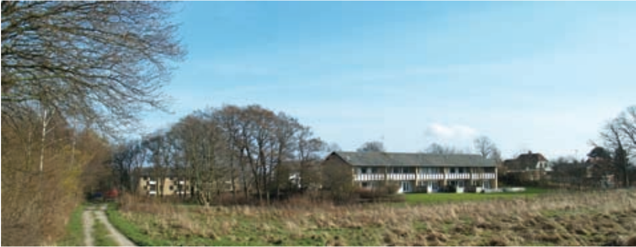
En lav slørende bevoksning, evt. i stil med kulissebeplantningen øst for huset, vil skabe en større landskabelig harmoni mellem det omkringliggende landskab og bebyggelsen. Tilsvarende beplantning er også med succes udført ved Fjordhus.
