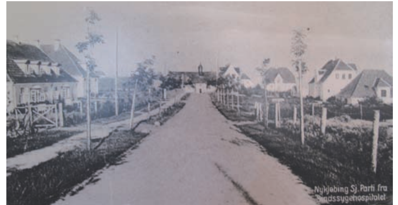
Den såkaldte "Landskabsallé" få år efter etableringen (Ca. 1920). Her set fra vest mod Administrationsbygningen.
